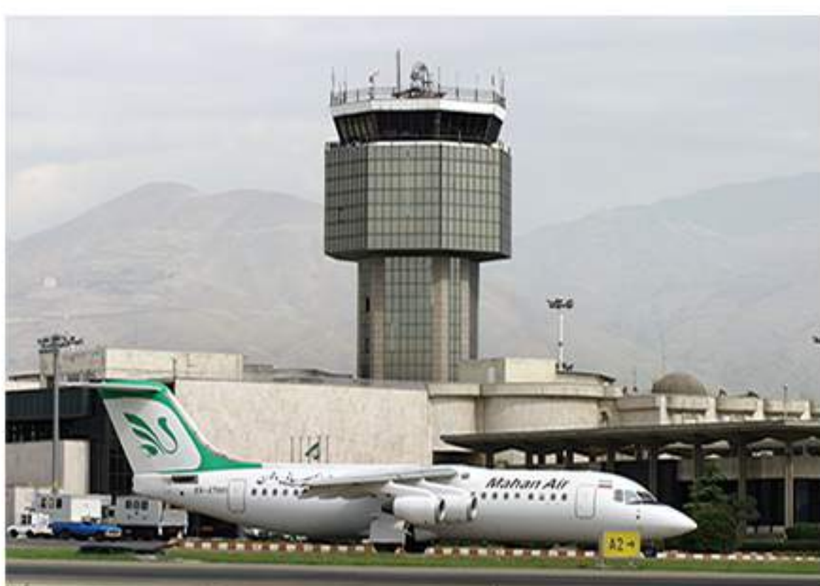
برج مراقبت فرودگاه مهرآباد
