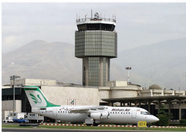
برج مراقبت فرودگاه مهرآباد
