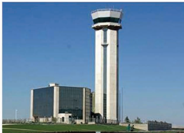
برج مراقبت فرودگاه امام خمینی
