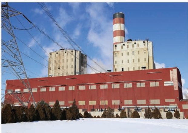
نیروگاه حرارتی تبریز
